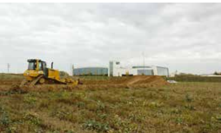
Prace już ruszyły
