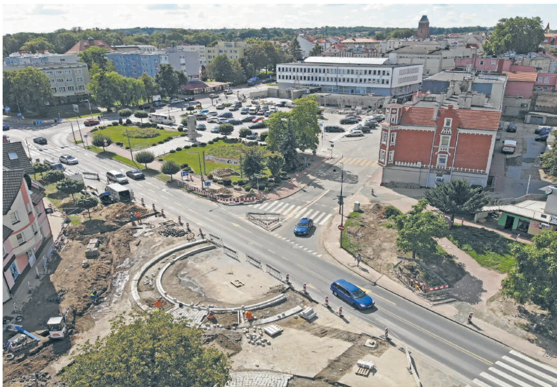
► Już w październiku pojedziemy, po w pełni otwartym małym węźle trzebnickim obejmującym rondo u zbiegu ulic: Milickiej, Roosevelta i H. Brodatego (przy sklepie DINO) oraz przy ul. Milickiej, Prusickiej, Ks. Bochenka i Witosa. Koszt tych inwestycji to blisko 4 mln zł.
