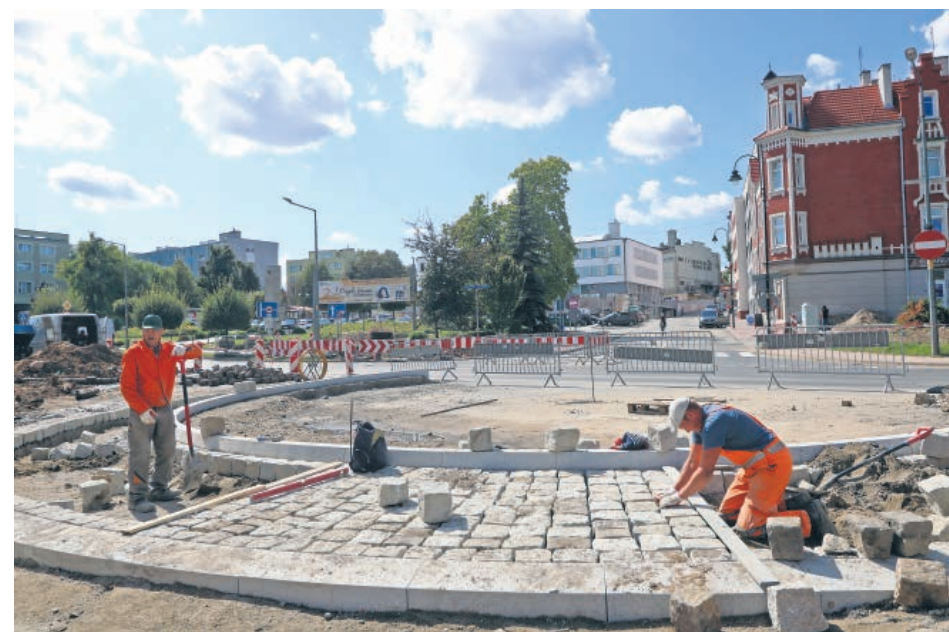
► Obecnie trwają prace związane z budową środkowego pierścienia głównego ronda.
